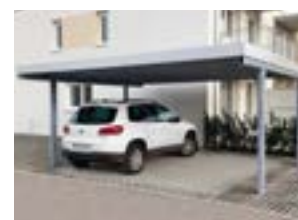
Prestrešenie parkovacích miest
