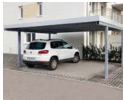
Prestrešenie parkovacích miest
