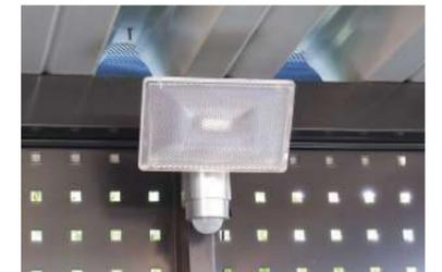
Ohne aufwendige Elektroinstallationen bringen sie bewegungsgesteuertes Licht in oder vor die Einhausung. Größe der Leuchte ca. 210 x 135 x 200 mm.
