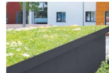
Natürliches Element im urbanen Raum, gepaart mit Vorteilen wie Lärmschutz und Regenwasserrückhalt. 40 mm hoch, bestehend aus Sedumschicht, Speichervlies, Gittermatte.
