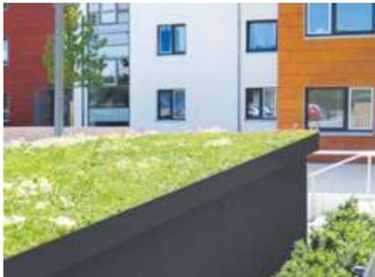
Natürliches Element im urbanen Raum, gepaart mit Vorteilen wie Lärmschutz und Regenwasserrückhalt. 40 mm hoch, bestehend aus Sedumschicht, Speichervlies, Gittermatte.
