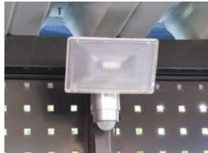
Ohne aufwendige Elektroinstallationen bringen sie bewegungsgesteuertes Licht in oder vor die Einhausung. Größe der Leuchte ca. 210 x 135 x 200 mm.
