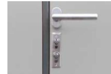
Durch den Einbau von 2 Zylindern kann der Müllabfuhr Zutritt gewährt werden.
